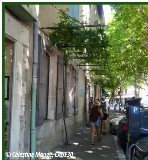
Dans le cas d'une végétalisation de façade, le dispositif doit être discret : câble métallique.
