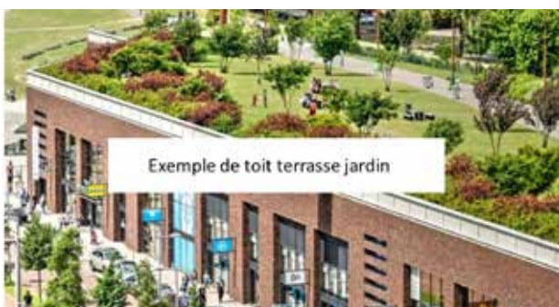
La réalisation d'un toit-terrasse a été plébiscitée
