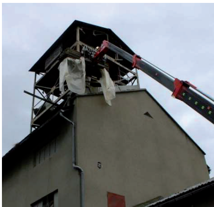
La déconstruction de 2019
