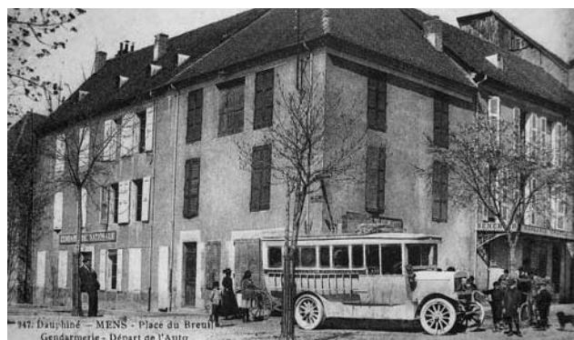
Ancienne rue de la poste : La gendarmerie et le départ de l'autobus
