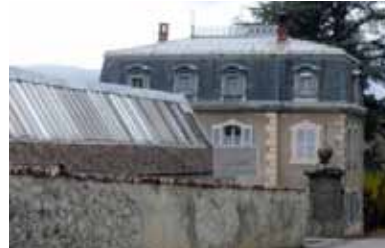
Usine Pétrequin : maison à toiture mansardée couverte d'ardoise et de zinc, atelier couvert de sheds (verrière, tuiles écaillées et zinc)
