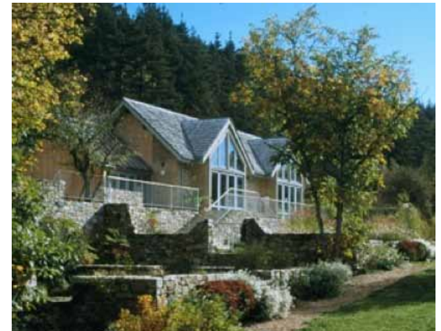
Exemple de serre bioclimatique intégrée à la conception architecturale – Centre Terre Vivante Les profils clairs se détachent du vitrage sombre. Des profils sombres seront demandés.
