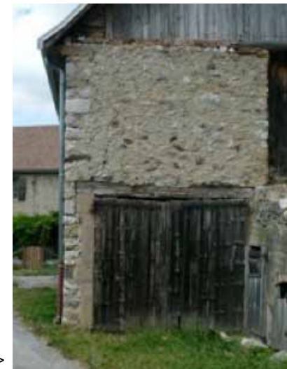
Exemple d'enduit à pierres vues sur une grange >
