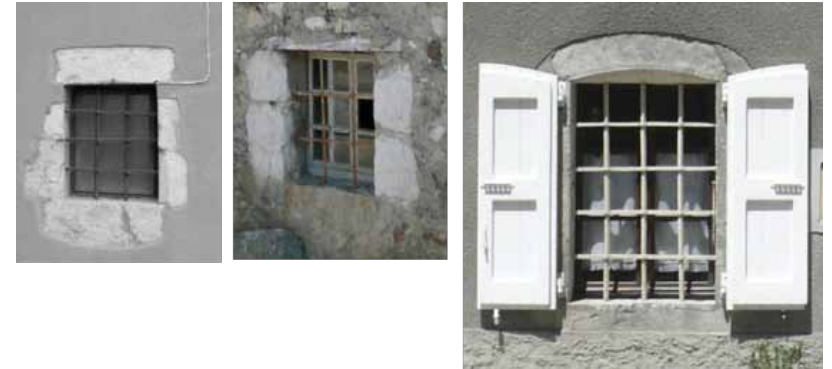
Exemples de grilles de protection anciennes
