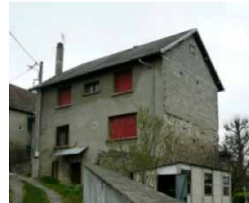
< Exemple d'aspect non fini interdit : mur en moellons en béton suite à la fermeture des combles initialement clos par un bardage bois.
