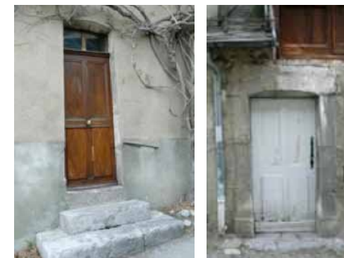
Exemple d'emmarchements en pierres taillées Exemple d'escaliers sur maisons rurales : béton et acier, bois
