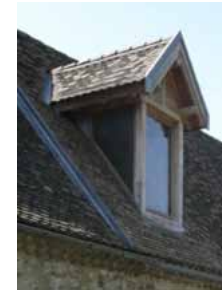
< Exemple de lucarne en bâtière à 2 pans avec jouées vitrées
