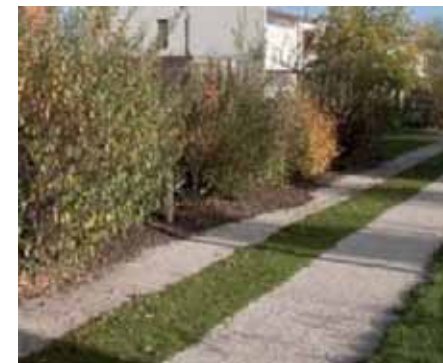
Exemple d'aménagement d'un chemin avec bandes latérales et bande centrale enherbée (ZAC Saint Jean des Vignes à Chalon-sur-Saône)
