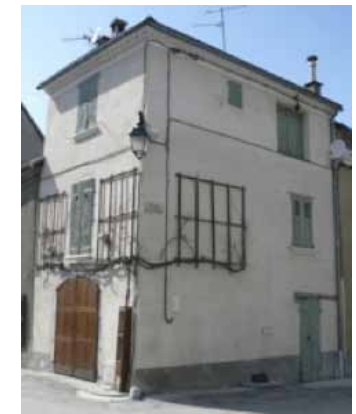
Exemples de treillage en façade : ancien et rénové
