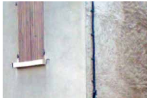
Exemple d'enduit frotté fin sur la façade principale et enduit fouetté en façade latérale
