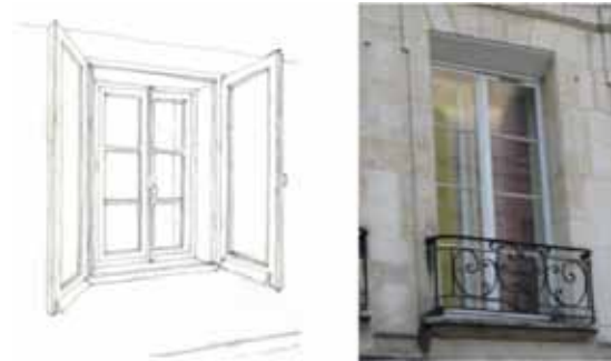
Exemples de double fenêtre intérieure, qui préserve l'aspect extérieur initial de la menuiserie ancienne (source : fiches ATHEBA)
