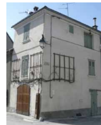
Exemples de treillage en façade : ancien et rénové
