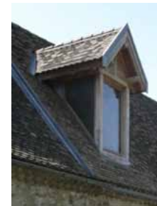
< Exemple de lucarne en bâtière à 2 pans avec jouées vitrées
