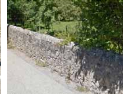
De gauche à droite : Mur de clôture avec couronnement en tuiles creuses et finition en enduit Mur de clôture en moellons de pierre apparents avec couronnement par glacis à 2 pentes En dessous : Profil de mur de clôture avec couronnement par glacis en arrondi et grille en fer plat
