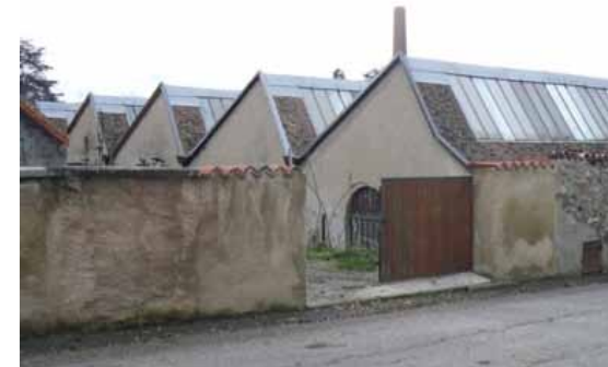
Sheds de l'ancienne usine Pétrequin : zinc, verrières, tuiles écaille
