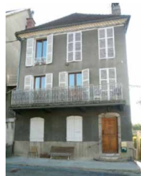
Exemple de fenêtres avec allège surbaissée (2ème étage) ; pose d'un garde-corps en ferronnerie dans le tableau de l'ouverture
