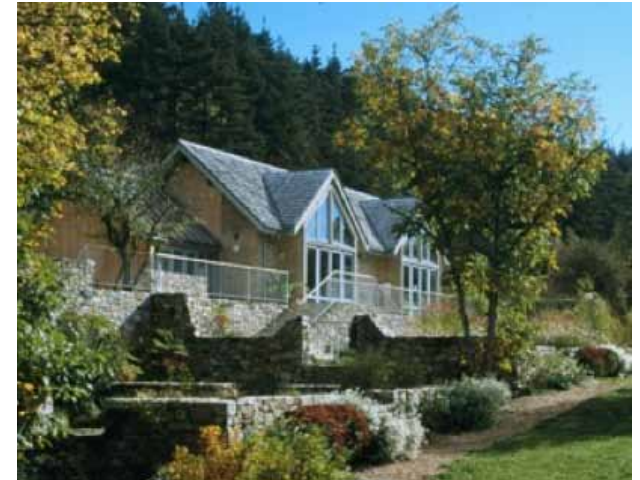
Exemple de serre bioclimatique intégrée à la conception architecturale – Centre Terre Vivante Les profilés clairs se détachent du vitrage sombre. Des profilés sombres seront demandés.
