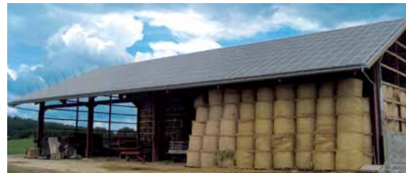
Exemple de pose de capteurs solaires photovoltaïques sur la totalité d'un pan de toiture d'une construction agricole - Source : CAUE 38 plaquette Bâtiments agricoles et photovoltaïques, décembre 2010
