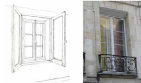
Exemples de double fenêtre intérieure, qui préserve l'aspect extérieur initial de la menuiserie ancienne (source : fiches ATHEBA)
