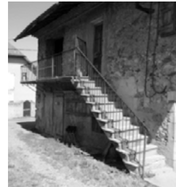
Exemple d'escaliers sur maisons rurales : béton et acier, bois
