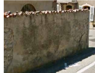
De gauche à droite : Mur de clôture avec couronnement en tuiles creuses et finition en enduit Mur de clôture en moellons de pierre apparents avec couronnement par glacis à 2 pentes En dessous : Profil de mur de clôture avec couronnement par glacis en arrondi et grille en fer plat
