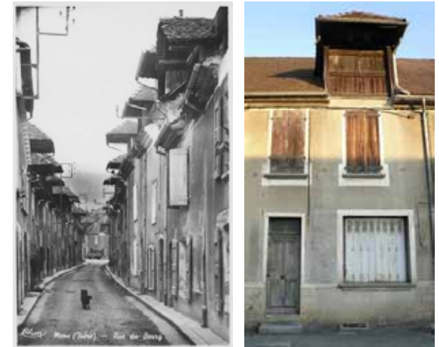
Maisons à engrangeou, rue du Bourg (source STAP 38), Maison à engrangeou, rue de l'Alpage
