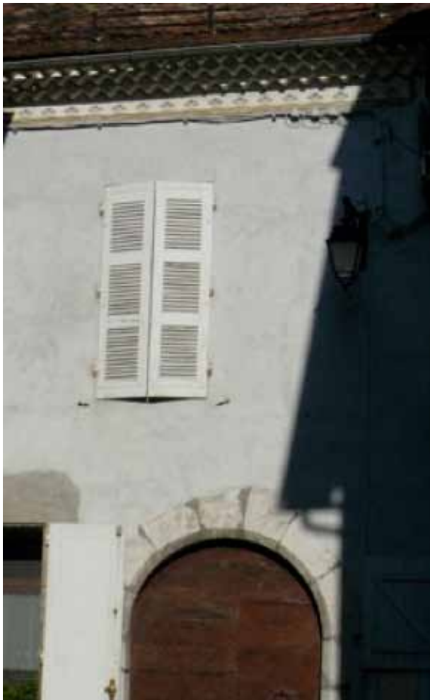
< Exemple d'enduit venant mourir au nu des pierres d'encadrement des portes du rez-de-chaussée ; motif peint au pochoir sur le bandeau sous génoise
