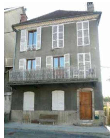
Exemple de fenêtres avec allège surbaissée (2ème étage) ; pose d'un garde-corps en ferronnerie dans le tableau de l'ouverture
