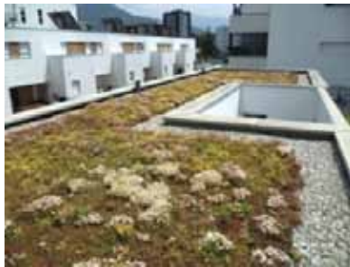
Exemples de toitures végétalisées
