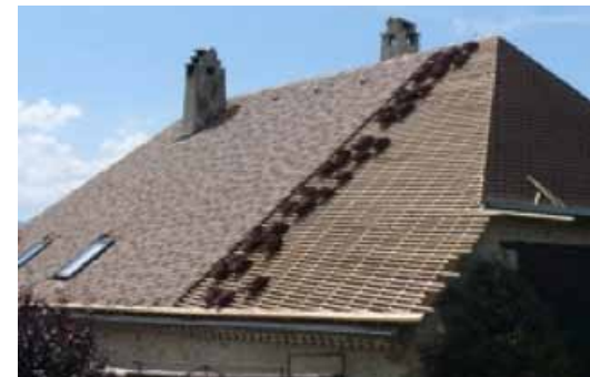
Exemple de rénovation de toiture en tuiles écaille
