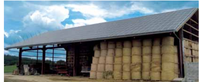
Exemple de pose de capteurs solaires photovoltaïques sur la totalité d'un pan de toiture d'une construction agricole - Source : CAUE 38 plaquette Bâtiments agricoles et photovoltaïques, décembre 2010
