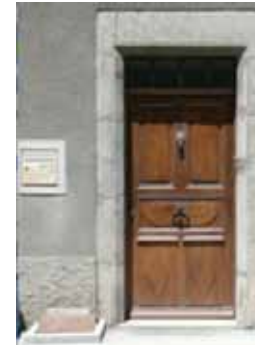
Exemple de boîte aux lettres encastrée en façade
