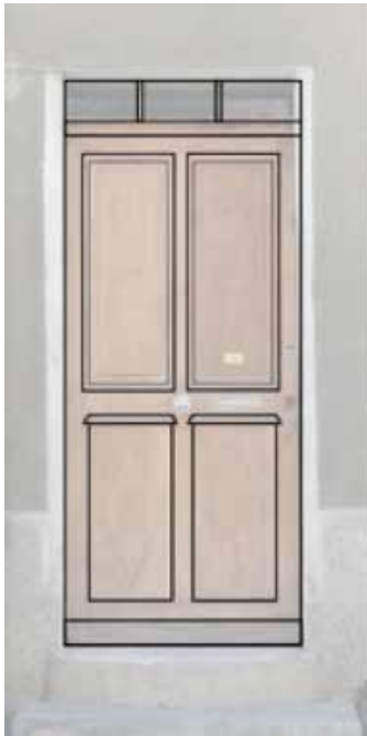
Porte type 1 – 4 panneaux 2 panneaux verticaux hauts en retrait par rapport au cadre 2 panneaux verticaux bas saillant par rapport au cadre
