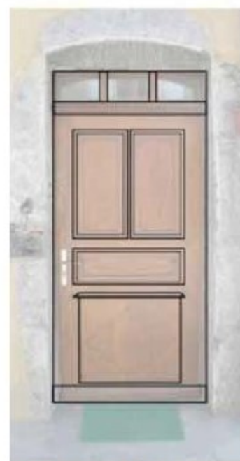
Porte type 5 – 4 panneaux 2 panneaux hauts verticaux en retrait par rapport au cadre 1 panneau médian horizontal en retrait par rapport au cadre 1 panneau bas carré saillant par rapport au cadre
