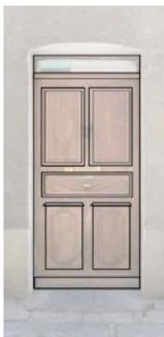
Porte type 4 – 5 panneaux 2 panneaux hauts verticaux en retrait par rapport au cadre 1 panneau médian horizontal en retrait par rapport au cadre 2 panneaux bas verticaux saillant par rapport au cadre
