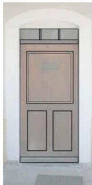
Porte type 2 – 3 panneaux 1 panneau haut carré en retrait par rapport au cadre 2 panneaux bas saillant par rapport au cadre
